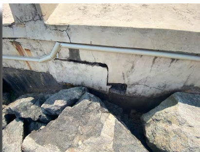
Extérieur : Mur front de mer
